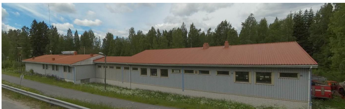
Kuva 46. Kiinteistö Oy Vilppulan Sähkölä
