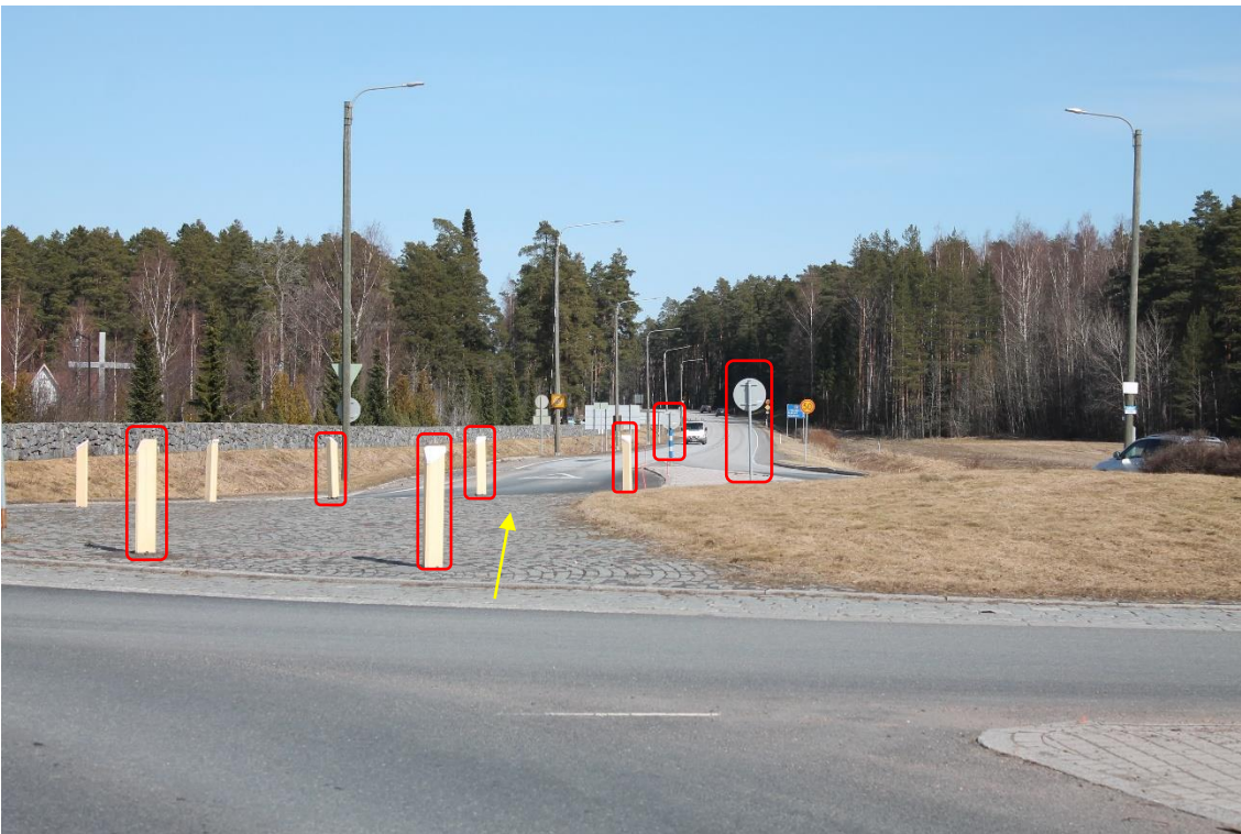
Pos 12 / Kuva 44. Tien 23 liikenneympyrä Noormarkussa. Ajetaan vastaantulevien kaistaa. Merkittyjä kylttejä ja pylväitä on poistettava.
