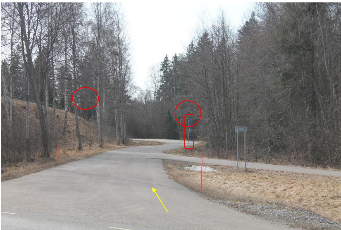
Pos 3 / Kuva 7. Sillan kiertoreitti tiellä 2. Merkitty kyltti on poistettava. Merkittyjä puunoksia on leikattava.
