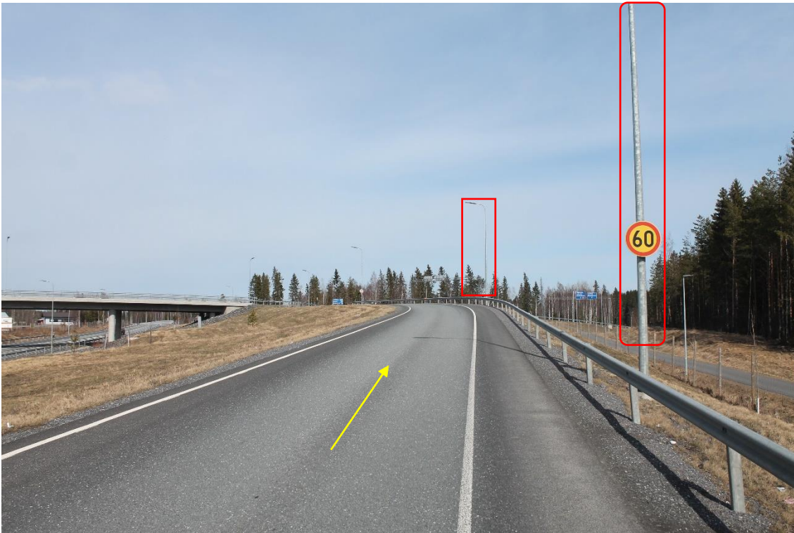
Pos 10 / Kuva 35. Kääntyminen tieltä 8 tielle 23. Merkittyjä valaisinpylväitä on poistettava.
