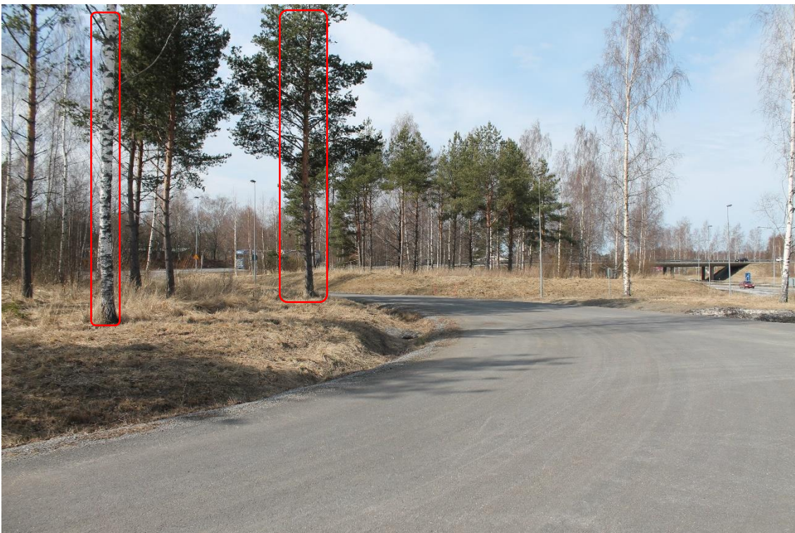
Pos 7 / Kuva 22. Kääntäminen tieltä 2 tielle 8. Kuljetusten on tehtävä U-käännös rampilla. Merkittyjä puita on kaadettava. Keltainen nuoli = tornit.
