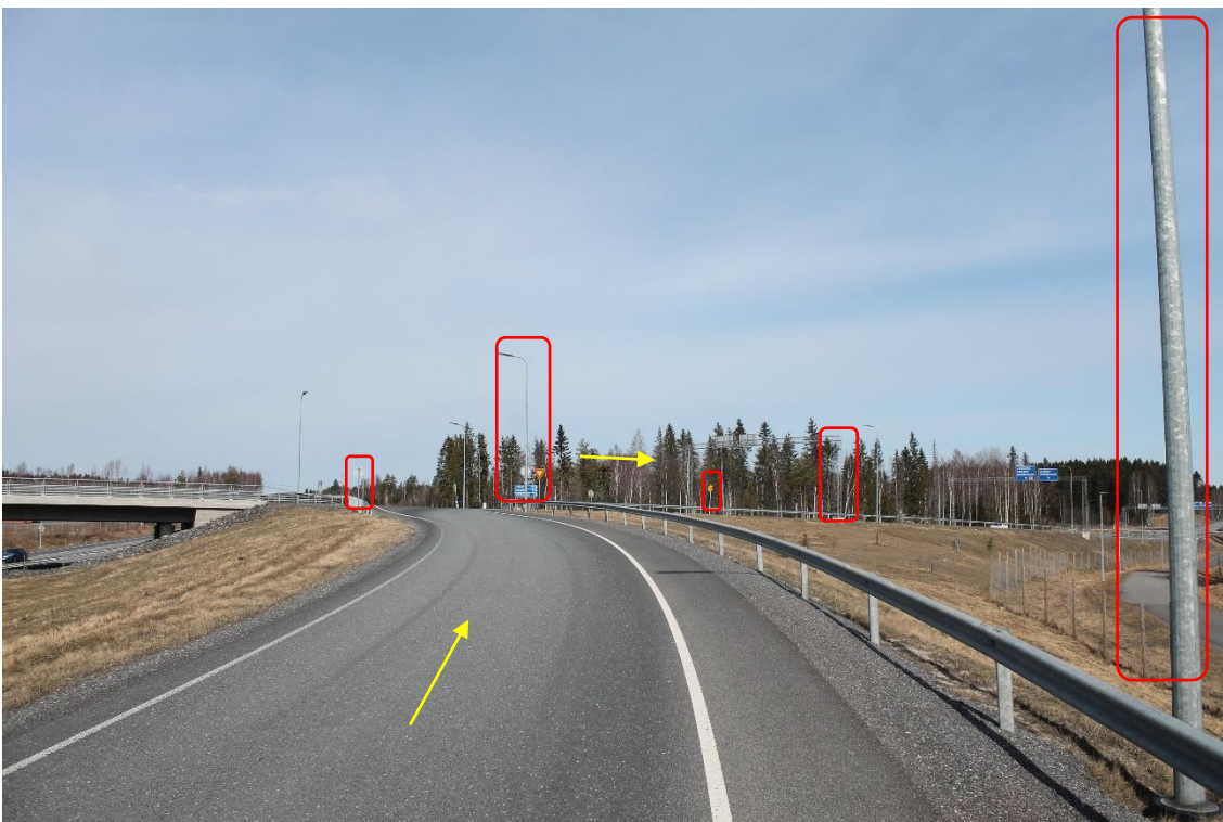
Pos 10 / Kuva 36. Kääntyminen tieltä 8 tielle 23. Merkitty portaalirakenne ja kyltit on poistettava.
