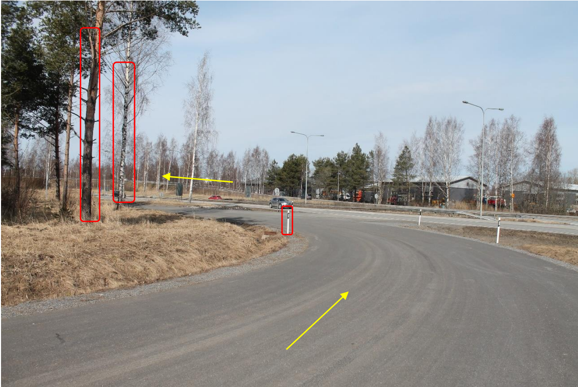
Pos 7 / Kuva 21. Kääntäminen tieltä 2 tielle 8. Kuljetusten on tehtävä U-käännös rampilla. Merkittyjä puita on kaadettava. Merkitty pylväk on poistettava. Keltainen nuoli = tornit.
