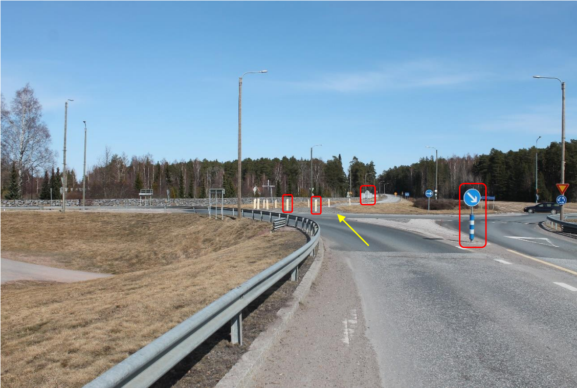
Pos 12 / Kuva 43. Tien 23 liikenneympyrä Noormarkussa. Ajetaan vastaantulevien kaistaa. Merkittyjä kylttejä ja pylväitä on poistettava.
