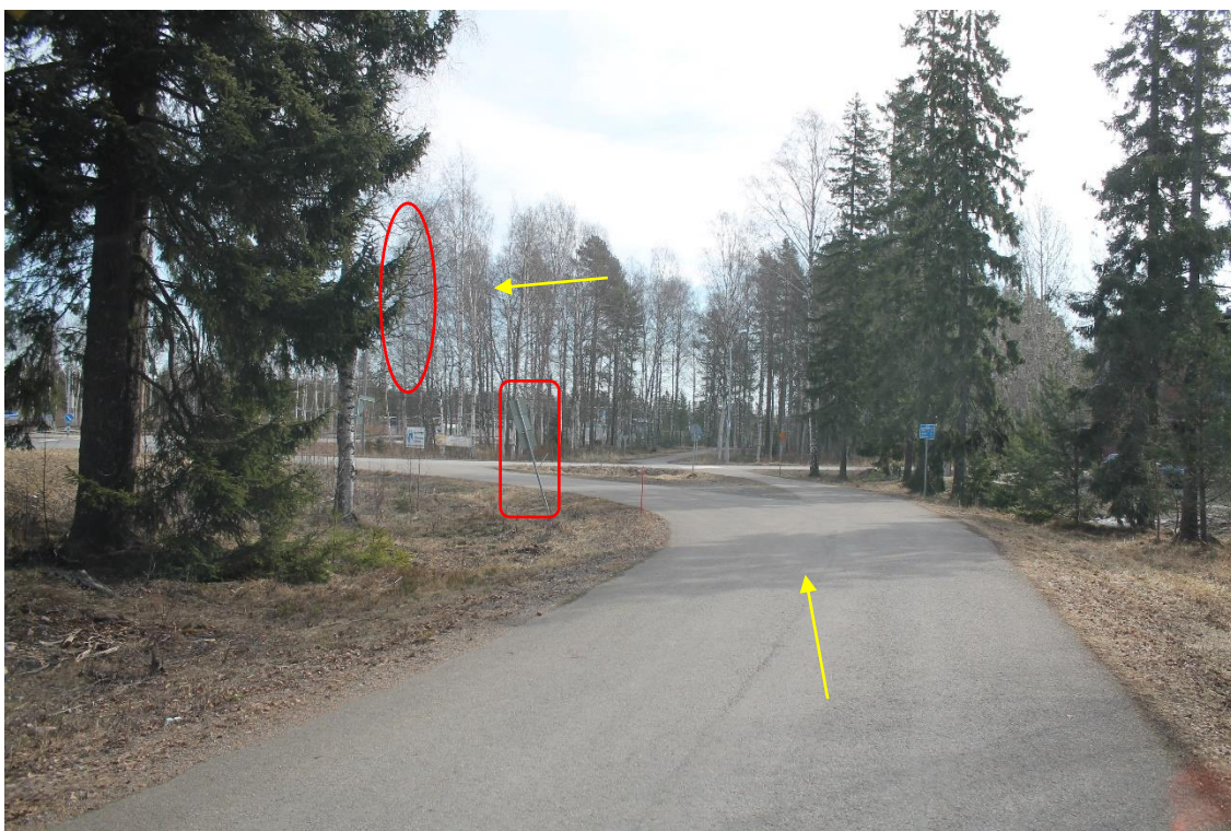
Pos 3 / Kuva 8. Sillan kiertoreitti tiellä 2. Merkitty kyltti on poistettava. Merkittyjä puunoksia on leikattava.
