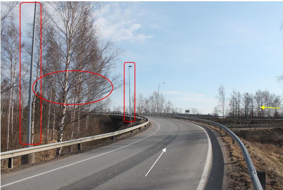
Pos 7 / Kuva 28. Kääntyminen tieltä 2 tielle 8. Merkittyjä valaisinpylväitä ja puita on poistettava. Valkoinen nuoli = siipien suunta.
