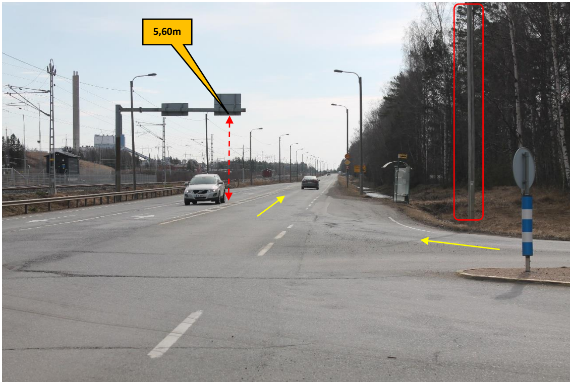
Pos 3 / Kuva 11. Tie 2, sillan kiertoreitti. Merkitty valaisinpylväs on poistettava.
