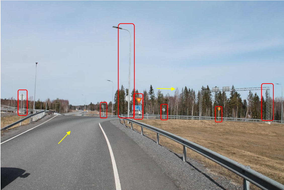
Pos 10 / Kuva 37. Kääntyminen tieltä 8 tielle 23. Merkitty valaisinpylväs, portaalirakenne ja kyltit on poistettava. Kaiteen korkeus 0,7 m.
