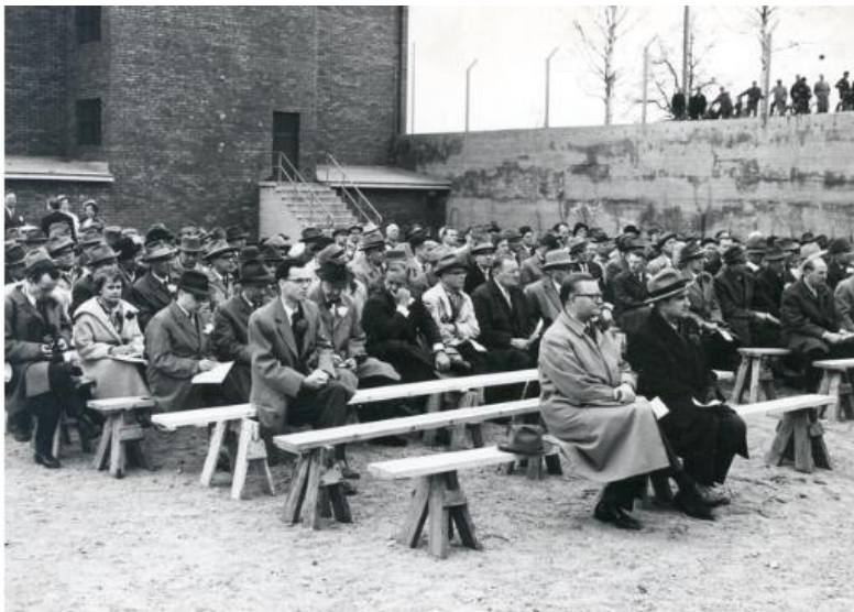
Vuonna 1955 kuorimon rakentamisen yhteydessä tehtiin suuret louhinta ja maamassan siirtotyöt. Maamassat käytettiin Mäntänlahden täyttämiseen voimalaitoksen hiilikenttää ja lumppuvarastoa varten. Tehtaankadun eteläpuolen loiva rinne leikattiin ja tasattiin. Tukimuurin korkeudesta näkyy Tehtaankadun maanpinnan taso. Kuvattu v. 1961 [5162GAS]
