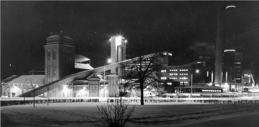
Tehtaankadun itäpään rakennuskantaa v. 1965. Laajennukset ovat tuoneet tehdasrakennukset jälleen kadun varteen. [6892GAS]
