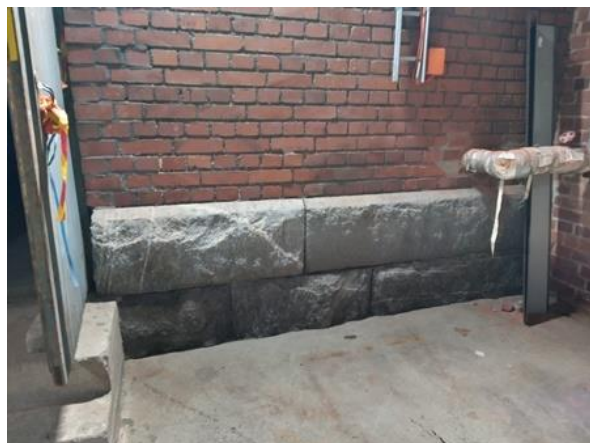
Vanhan ja uuden osan liittymäkohta. Oikealla pätäkä vanhaa ulkoseinää ja perustusta.
