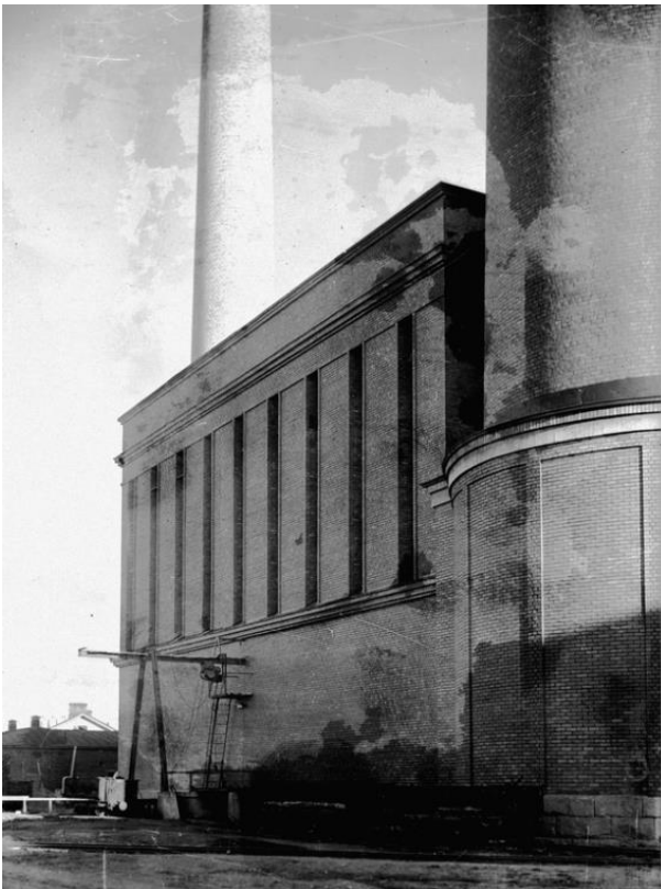
Uusi höyryvoimalaitos rakenteilla v. 1934. Iso piippu on muurattu jo pikkupiipun korkeudelle.
