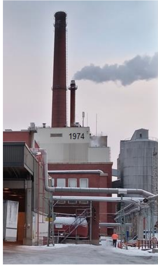
Voimalaitos kuvattuna lännestä tehdaspihalta v. 1963 ja marraskuussa 2021. Harmaa osa on v. 1974 laajennus. Lisäksi etualalla ovat valkaisimon ja koskitalon rakennukset. Oikealla valkaisimon massasäiliöt. [6755GAS]
