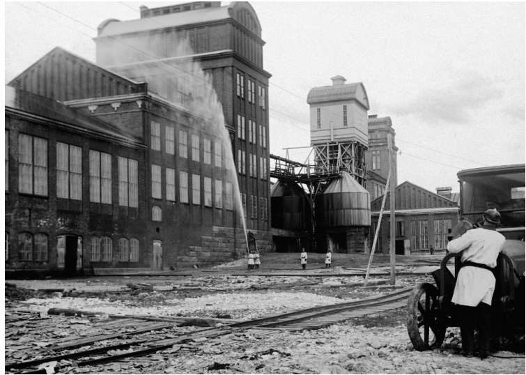
Happosäiliö happotornin ja keittämön välissä. [06085KEL] Säiliöiden muoto muuttui vuosikymmenien aikana mutta lohkokiviperusta pysyi samanlaisena. Oikealla testataan konepajan valmistamaa ruiskua 1920-luvulla. [21775KEL]
