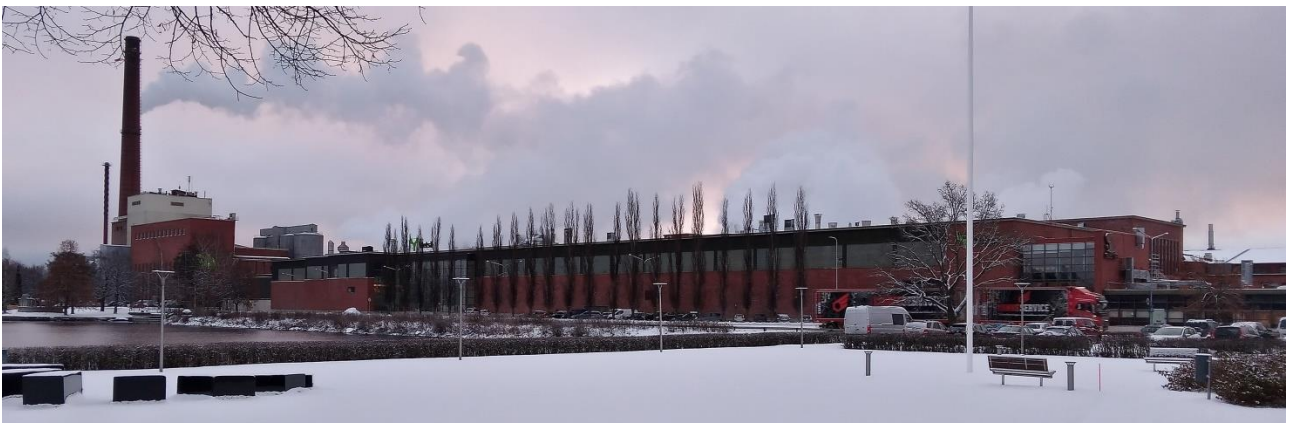
Tehdasalueen itä- ja länsipuoli erottuvat selkeästi rakennusten massoittelun osalta.
