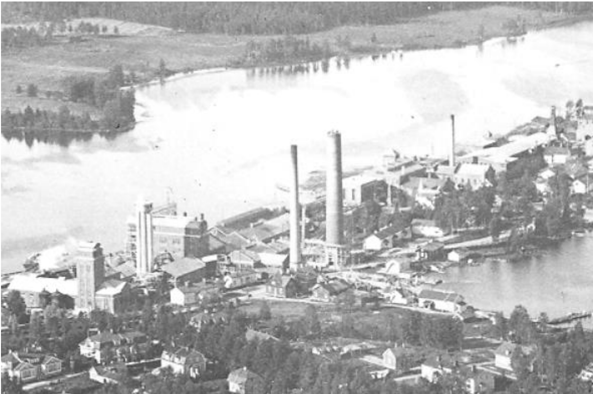
Uusi höyryvoimalaitos rakenteilla v. 1934. Iso piippu on muurattu jo pikkupiipun korkeudelle.
