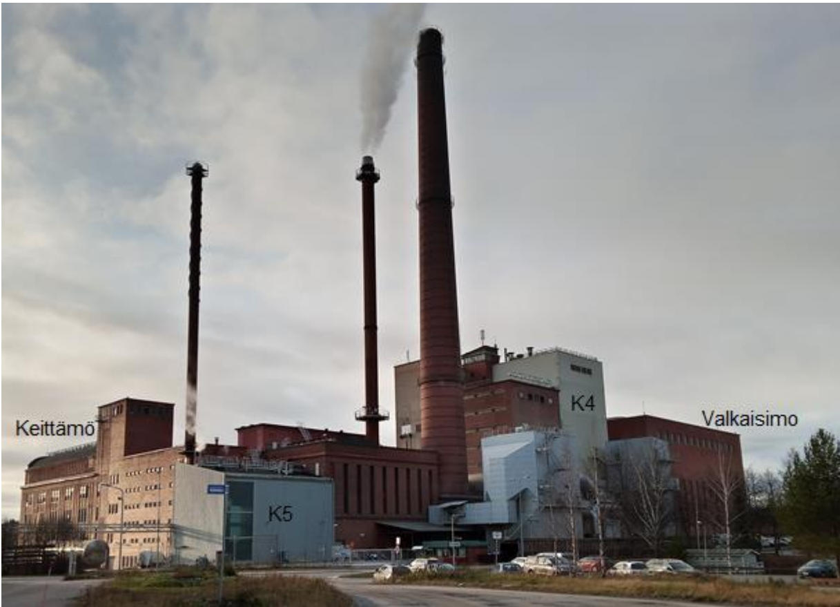
Mäntän Energia Oy:n voimalaitos marraskuu 2021. Voimalaitoksen rakennukset jäävät keittämön ja valkaisimon väliin. Etualalla harmaa kattila K5 (v.2017) ja K4 ovat nykyisin ainoat käytössä olevat kattilat. 1930-luvun laitoksen kattilahuoneessa on nykyisin savukaasupesuri. 1950-luvun laitoksen turbiinisalissa on AEG:n turbiini edelleen käytössä. Harmaat laitteistot rakennusten edustalla ovat suodattimia, joista vanhempi (vasemmalla) jäi pois käytöstä 2017. Kuvattu koillisesta Pekilon pihalta.
