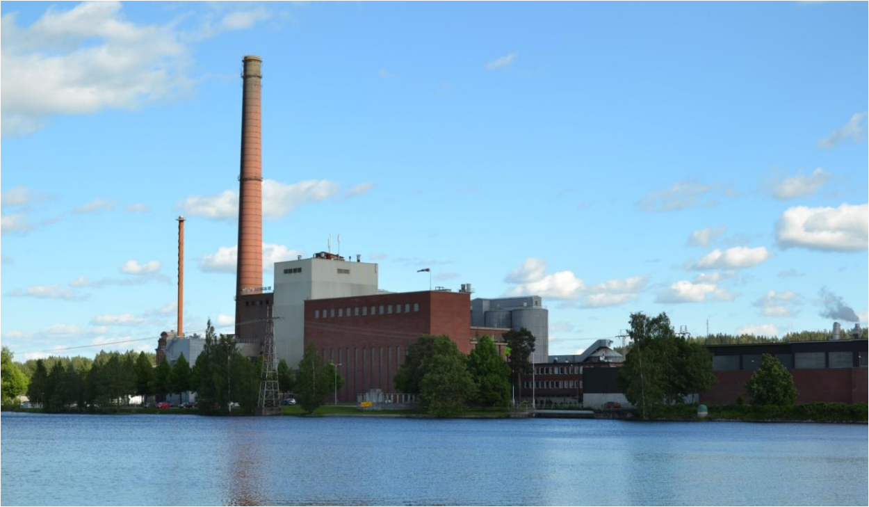
Höyryvoimalaitoksen laajennus v. 1974 on korkea harmaa osa valkaisimon vasemmalla puolella. Höyryvoimalaitos piippuineen yhdessä valkaisimon kanssa on Mäntän näkyvin maamerkki. cc by-SA 3.0
