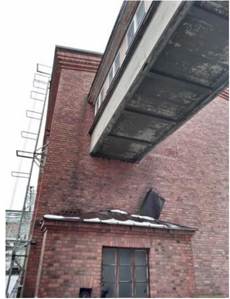
Länsiseinä ja yhdysilta.
