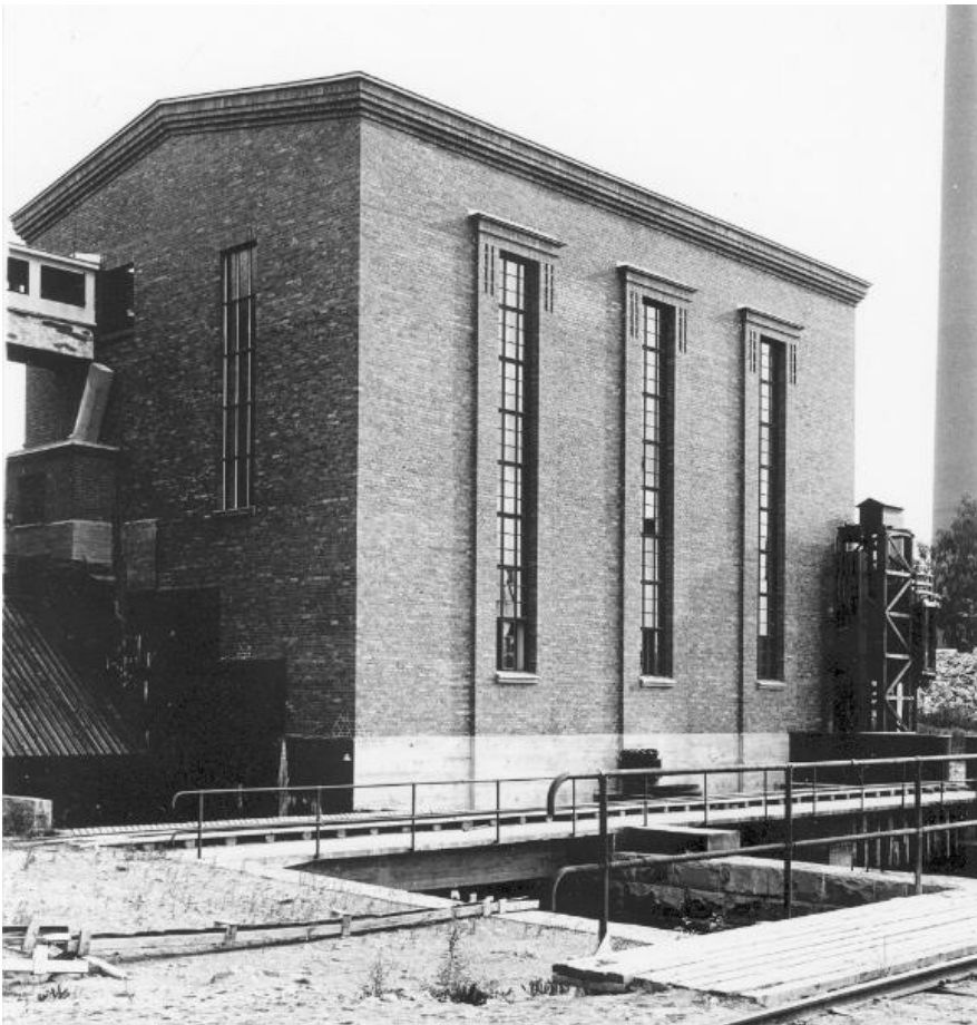
Mäntän vesivoimalaitos v. 1934 kuvattu lounaasta. [6505GAS]
