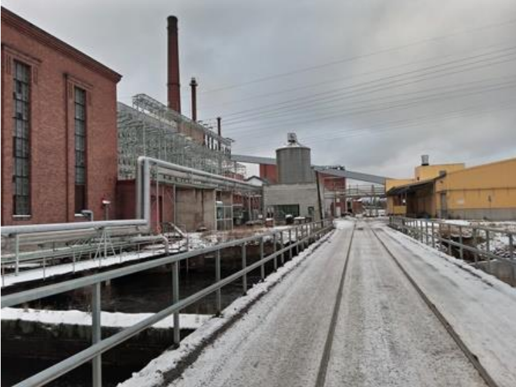
Rautatiesilta voimalaitoksen eteläpuolella. Näkymä itään 2021.
