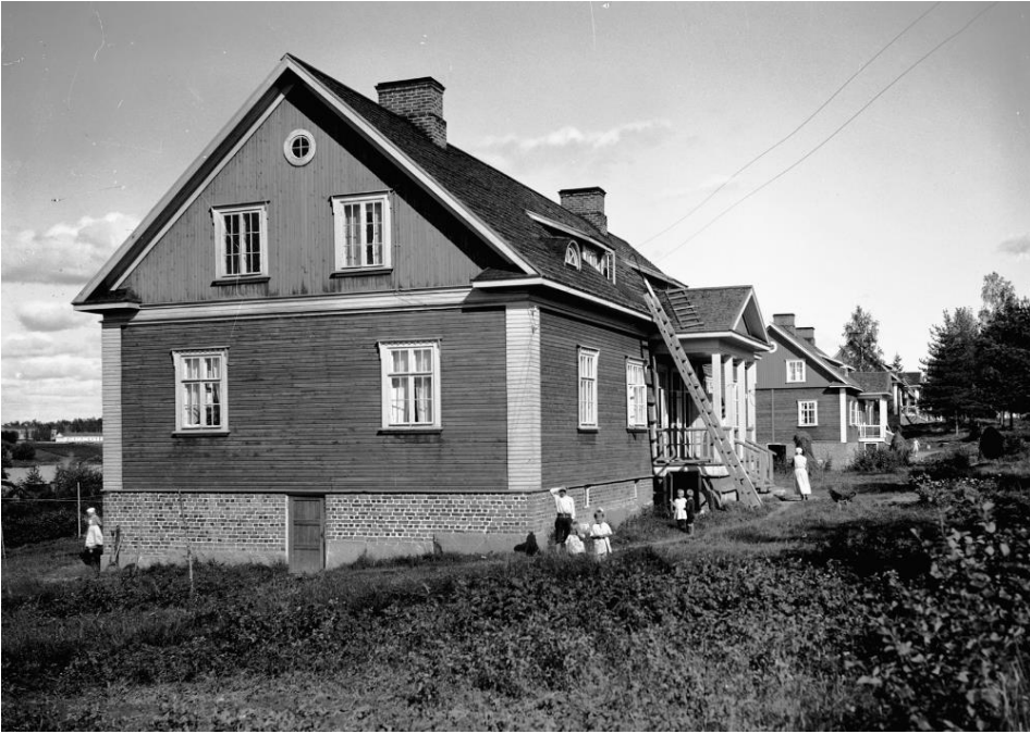
Pättiniemen mallitalot 1920-luvulla. Rakennukset noudattavat tyyppiä, mitä erikokoisina toteutettiin Mänttään 1920-luvullakin; Korkea kivijalka tai tiilestä muurattu kellari, satulakatto, neljä- tai kuusiruutujaolliset ikkunat, avokuistillinen sisäänkäynti. [21600KEL]
