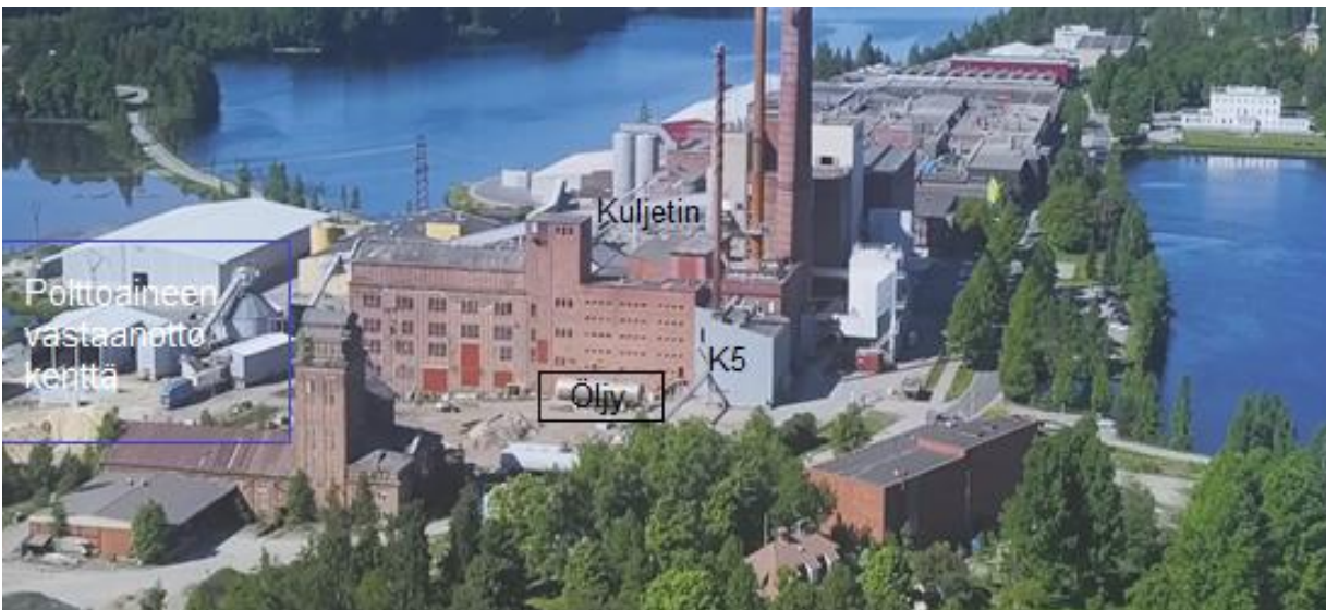
Höyryvoimalaitoksen polttoainevarastot sijaitsevat keittämön ja sprittehtaan välisellä alueella.
