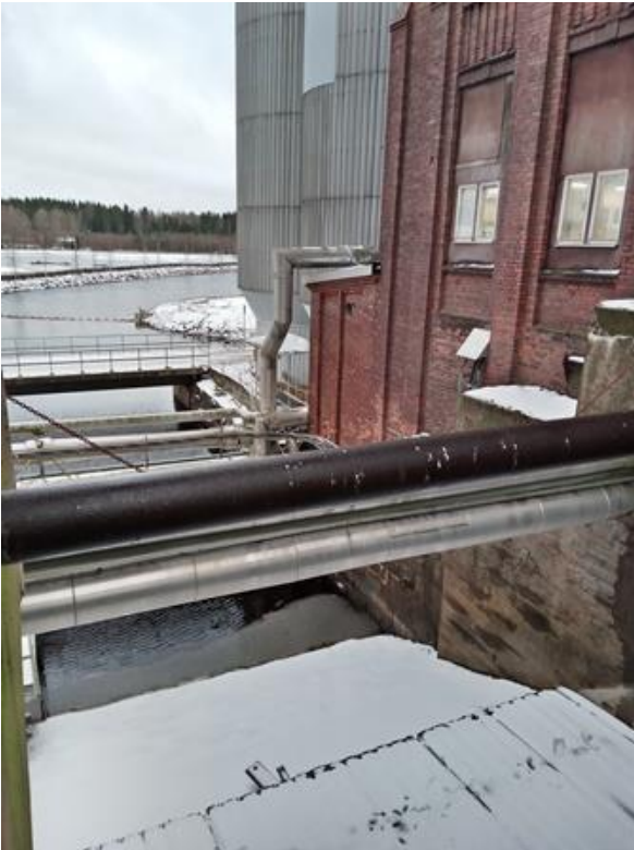
Ohjuksutusluukku ja paperitehtaan seinä.
