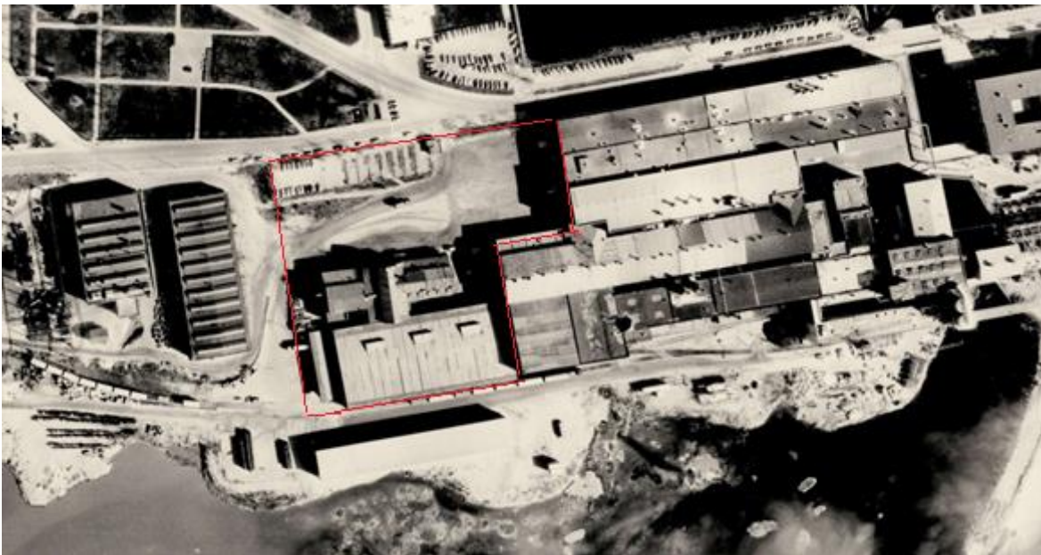
Paperitehtaan ja konepajan alue v. 1976. Uusi jalostusosasto rakennettiin punaisella rajatulle alueella 1980-luvulla.
