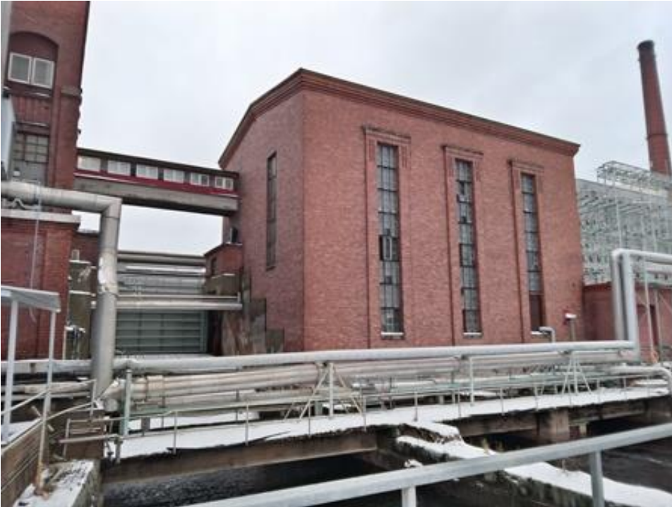
Eteläinen julkisivu marraskuu 2021.
