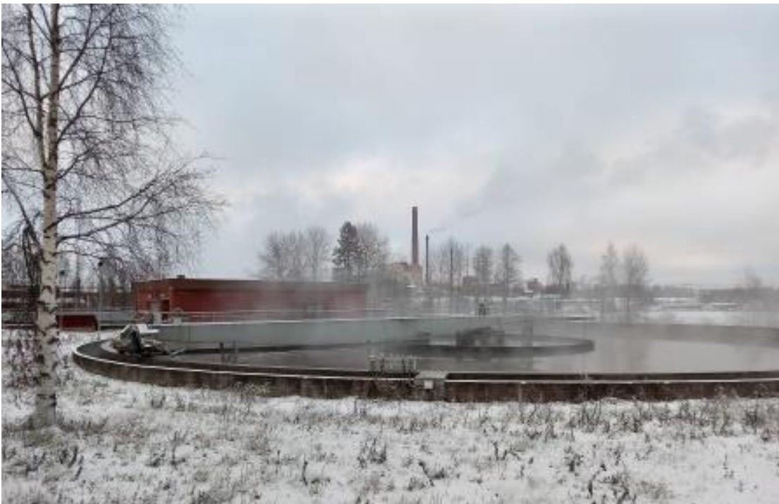
Jätevedenpuhdistuslaitos Pättiniemessä marraskuussa 2021. Tehdasalue taustalla.
