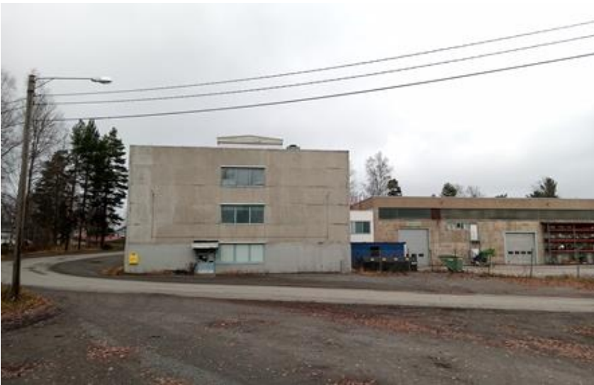
Toimistorakennuksen eteläpää 2021 Lahdenpohjantielle lokakuu 2021.
