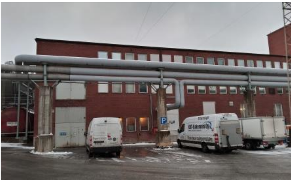
Eteläinen julkisivu tehdaspihalle 2021.
