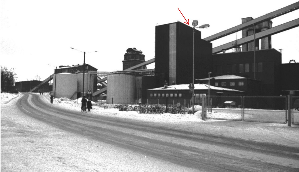
Uusi spriitehdas v. 1981 Tehtaankadulta kuvattuna. Rakennuksen suunnitteli arkkitehtitoimisto Kalle Vartola. Rakennus ja oheislaitteet purettiin 1990-luvun alussa.[10793KEL]
