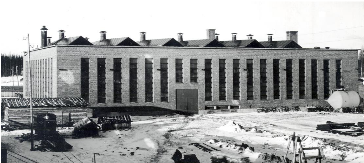
Paperitehtaan puoleinen (itäinen) julkisivu. [0188GAS]
