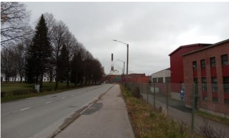
Entisen kokoonpanohallin ja valimorakennuksen päädyt Tehtaankadulle 2021.
