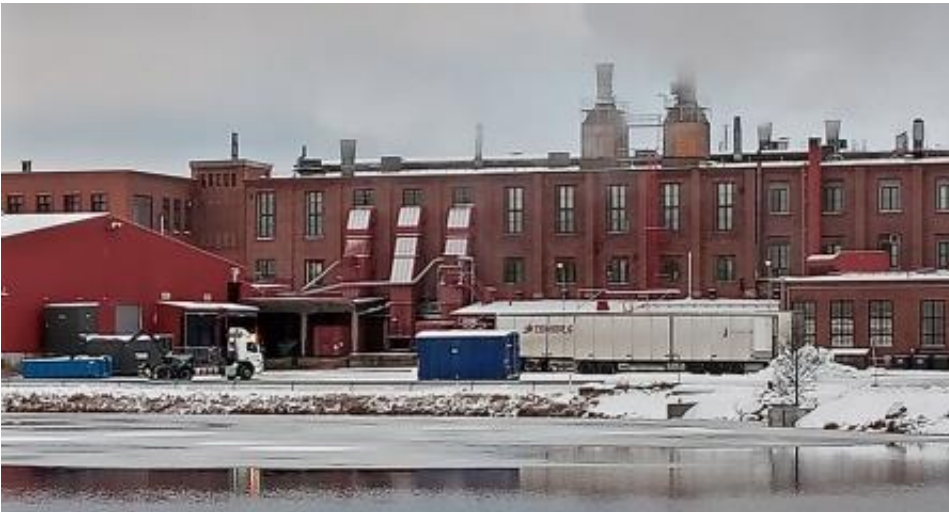
Vanhaa 1900-luvun alun punatiiliseinä. Vanhassa osassa sijaitsee tehtaan ruokala.
