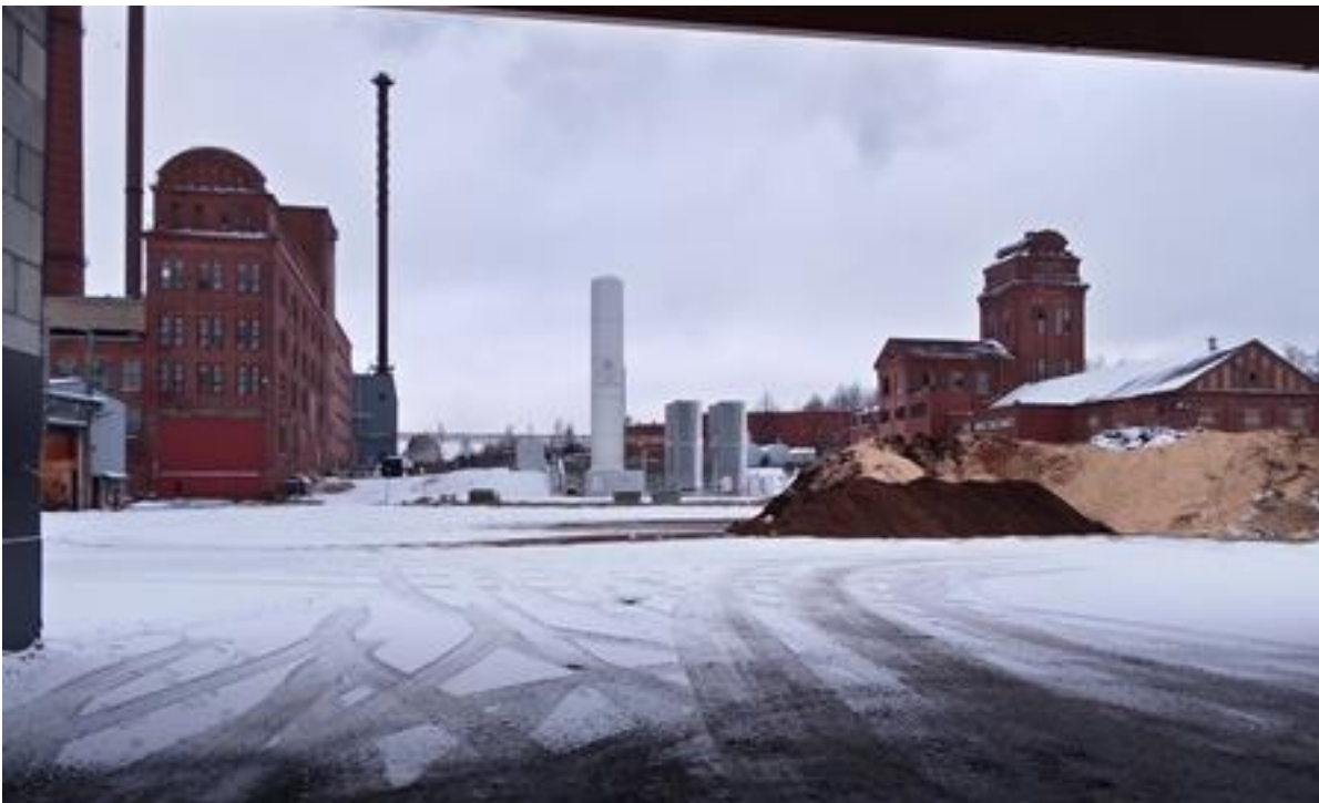
Keittämö ja spriitehdas kuvattuna etelästä marraskuussa 2021.
