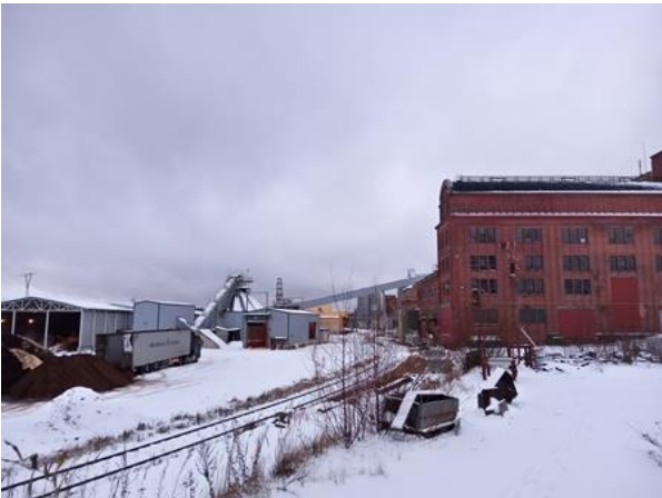
6. Voimalaitoksen energiapiha, sellutehtaan kaakkois- ja eteläpuolella. Laaja kenttä jossa on läjityskasat, kuljettimet, katokset ja polttoainesäiliöt.
