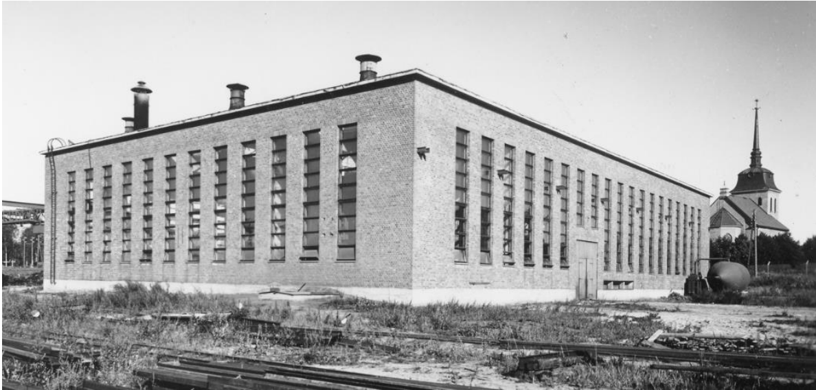
Arkkitehti Heimo Kautosen suunnittelema valimorakennus. [2457GAS] Konepajan valimorakennuksen harjannostajaisia vietettiin 9.2.1946. 2
