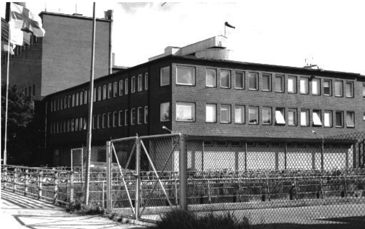
Koskitalo korotettuna v. 1984. Rakennuksen kulmia on korostettu sijoittamalla niihin suuremmat ikkunat. Tehtaankadulta kuvattuna. [11937KEL]
