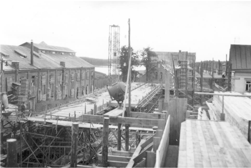
PK V Sali rakenteilla v. 1928. Taustalla tehtaansauna ja konepaja. [6335GAS]
