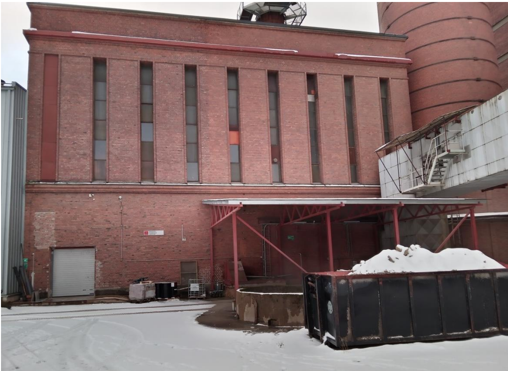
Julkisivu Tehtaankadulle. Nykyisin tilassa sijaitsee voimalaitoksen savukaasupesuri.
