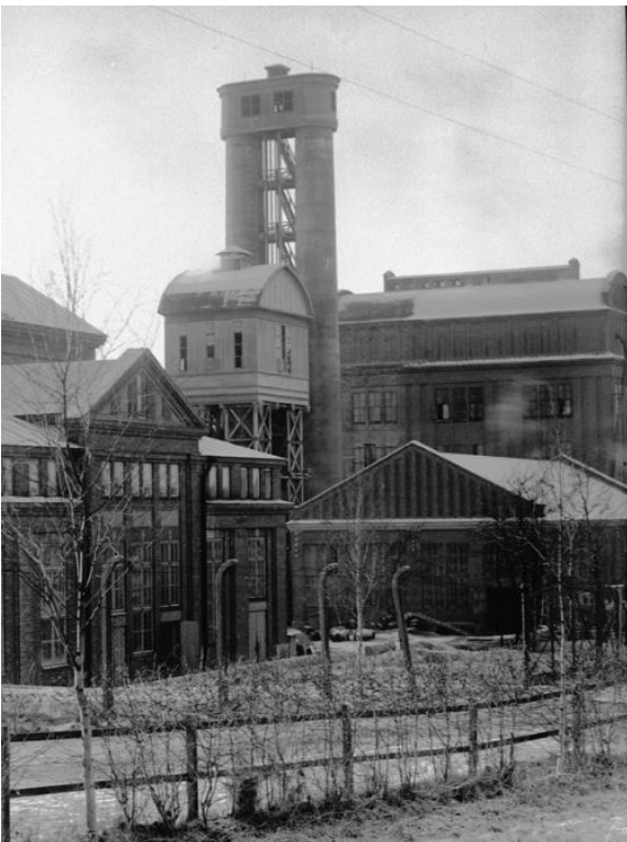
Happotornien 2. vaihe ja ensimmäinen betonitorni 1920-luvun puolivälissä. Keittämöä on laajennettu yhdellä keittokattilalla. Vasemmalla näkyy osa spritehtaasta, kuorimo, happotorni ja keittämö. [21759KEL] Oikealla keittämö, happotornit ja taustalla sellutehtaan höyryvoimalaitoksen piippu. [21669KEL]
