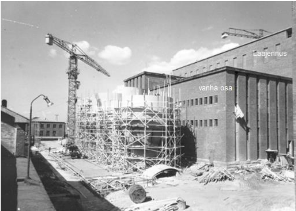
Valkaisimon laajennus v. 1965 sakean massan säiliöt. Vanhalle puolelle sijoitettiin selluloosatehtaan varastointi- ja lajittelutilat sekä valkaisukemikaalien valmistus. Kuvattu tehdasalueen puolelta. [6901GAS]
