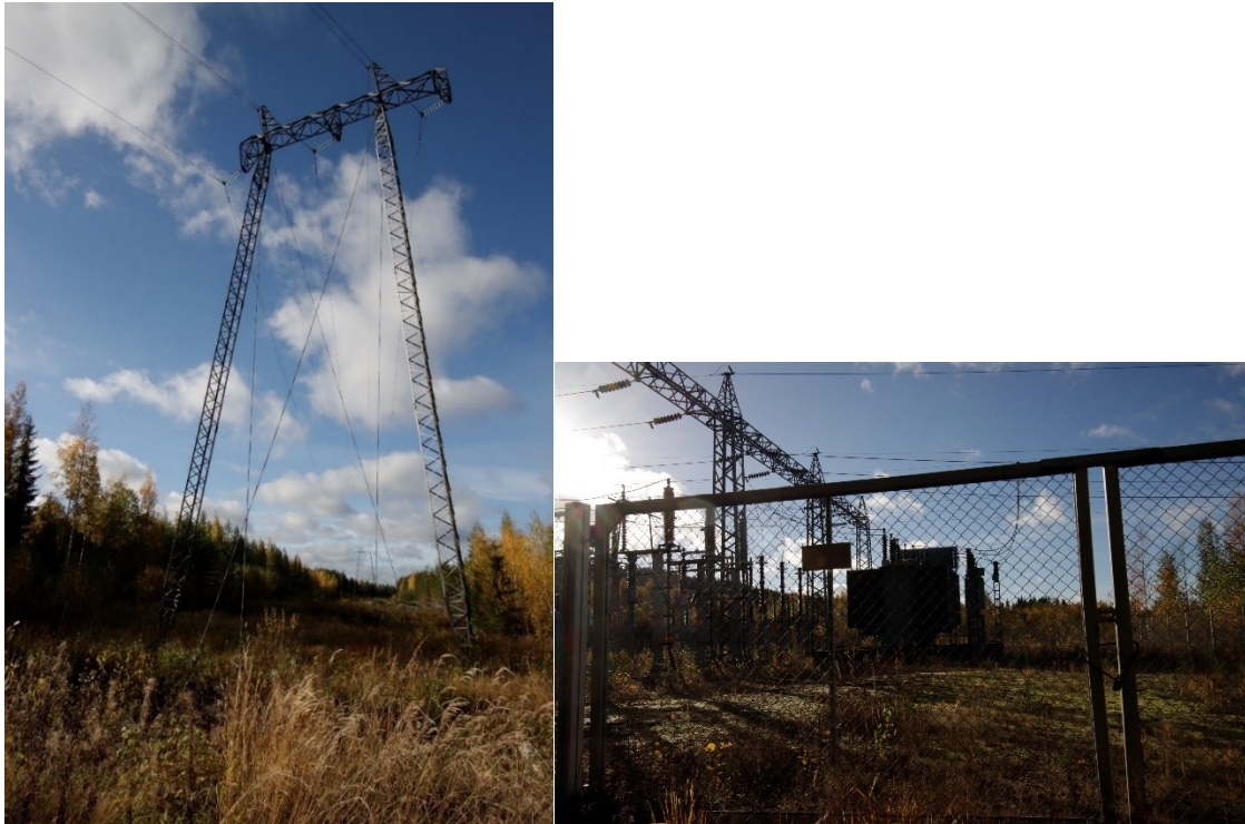
Kuva 22 ja Kuva 23. Suunnittelualueen läpi kulkee n. 50 m leveä johtokatu ja 110 kV voimalinja, ja alueen kaakkoisosassa on muuntoasema.
