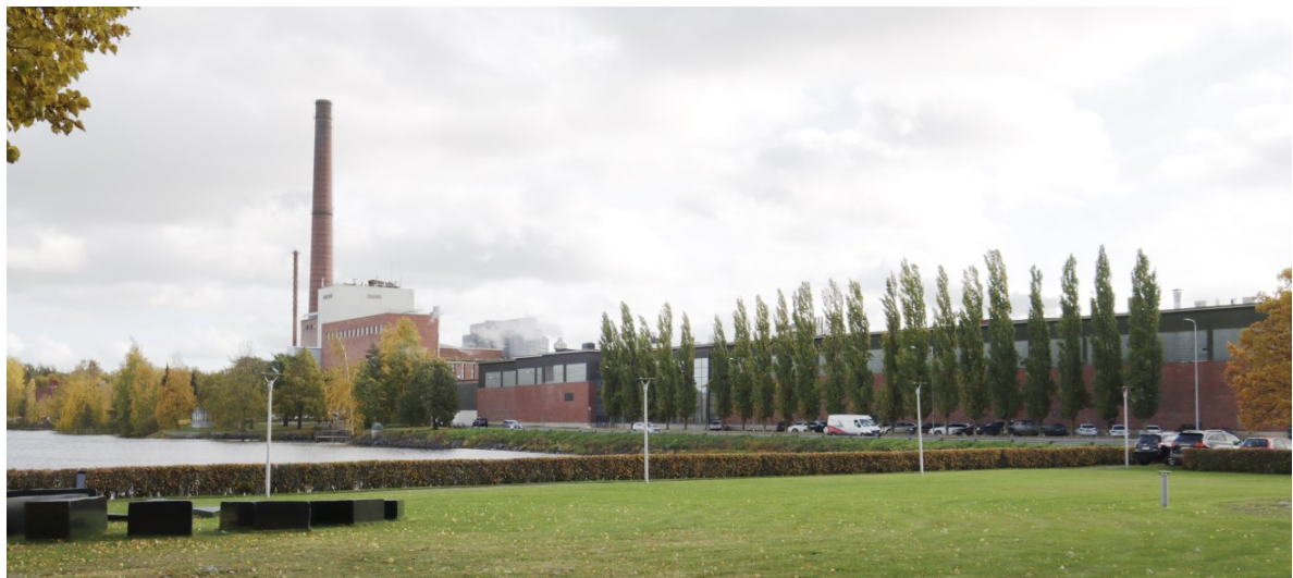
Kuva 27 Mäntän tehtaatan pohjoisjulkisivu kuvattuna Koskelanlammen länsirannalta. Kuva FCG, maastokäynti 7.10.2022.
