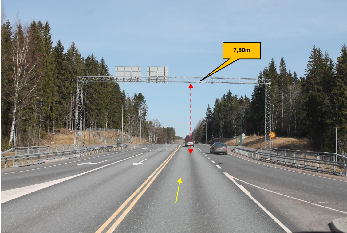
Pos 11/Pic 41. Road 23. Modifications : N/A.
