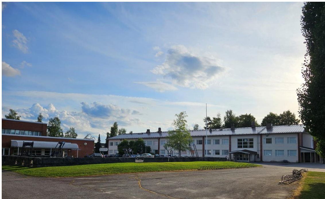
Kuva 12. Koskelan yläkoulu/lukiorakennus ja liikuntasali/ruokala
