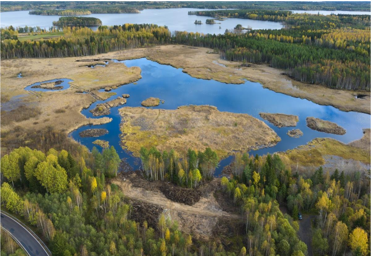
Kuva 6. Ruoppausalueet ja läjitysalue (etualalla) 13.10.2023 töiden valmistumisen jälkeen.
