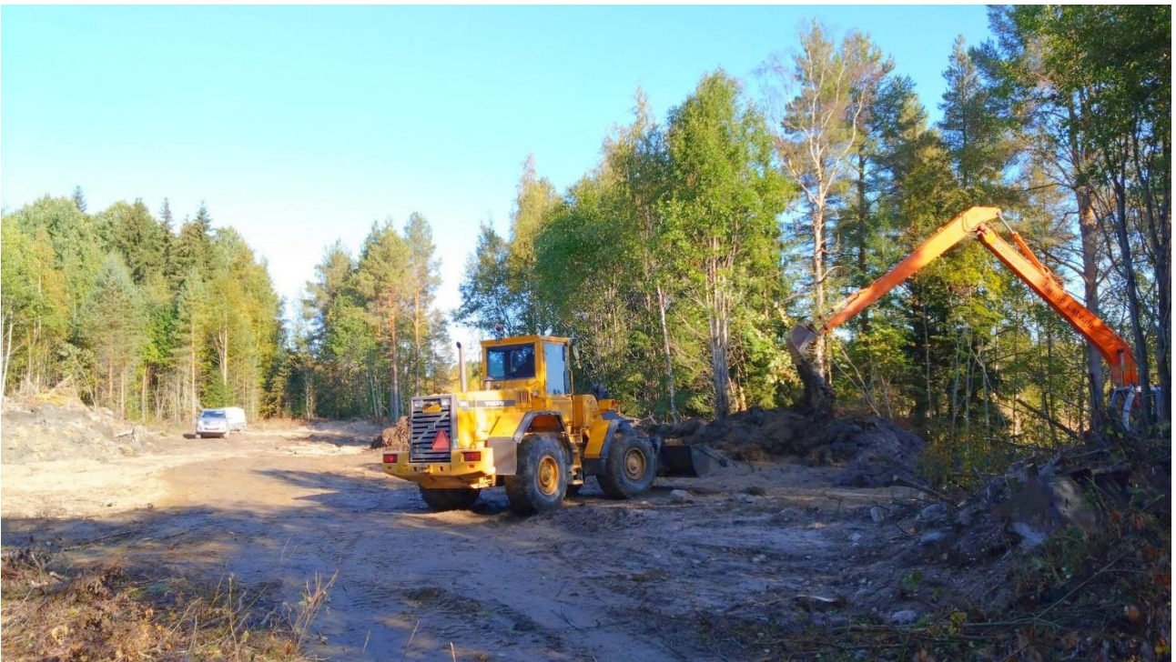
Kuva 11. Ruoppausmassat läjitettiin entiselle pylväskentälle järven länsipuolella.
