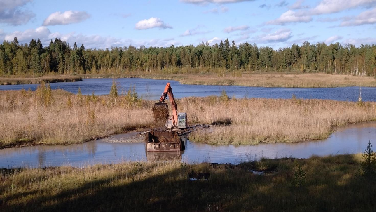
Kuva 8. Ruoppaus toteutettiin kelluvalla kaivinkoneella ja massat kuljetettiin maalle kaivinkoneen työntämällä proomulla.
