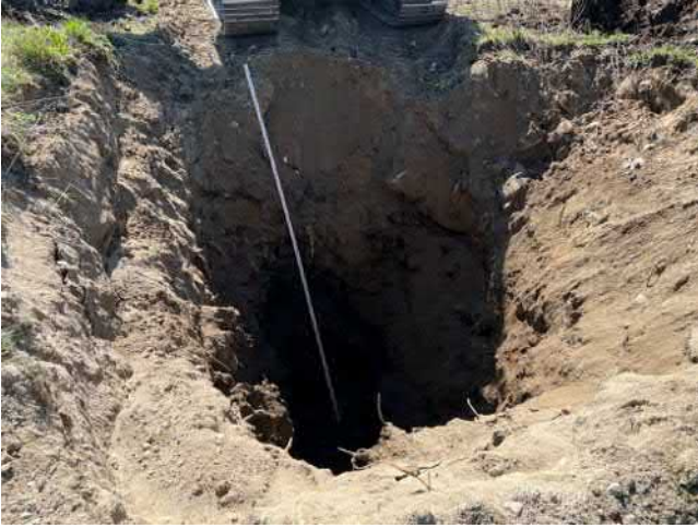
KK7 toiselta reunalta syvyyttä noin 7m. Toinen reuna alempana noin 5m, kerrosten syvyydet mitettu korkeammasta reunasta
