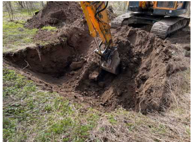
Kk1 +2m, paljon lohkarettä ja muutamia metalliroskia
