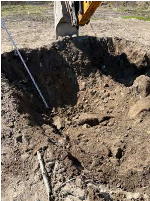
KK10 2m kaivettu. Ei jätteitä. Siirrytään seuraavaan.
