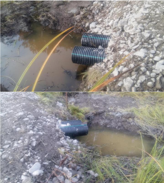
Kuva 15. Väliaikainen pengertie kaksi 20 cm halkaisijaltaan olevien putkien yhteispinta-ala on vain 0,062m 2 , mikä on ollut riittämätön salmen luontaisen virtaamaolosuhteiden turvaamisessa (kuvaaja Marjanne Virkajärvi).
