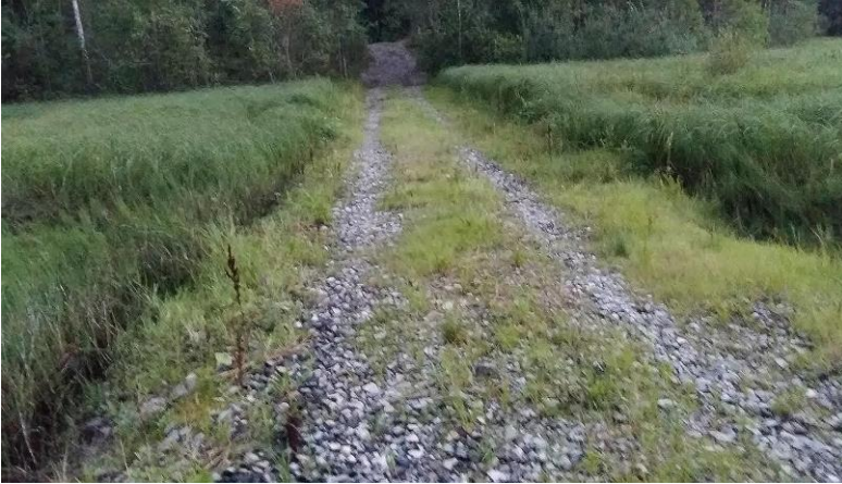
Kuva 14. Väliaikainen pengertie on estänyt veden virtauksen kaikilla vedenpinnan korkeuksilla, mikä on veden virtaaman luontaisen puhdistus prosessin (kuvaaja Marjanne Virkajärvi).
